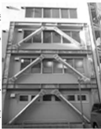
◀南側に設置した耐震ブレース
